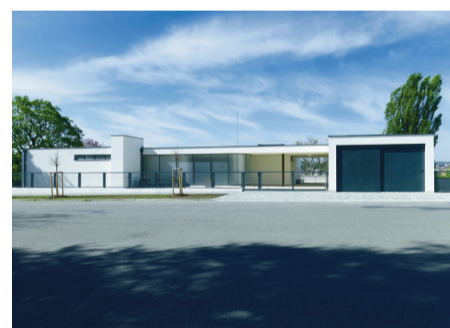
Rekonstrukce vily Tugendhat v Brně OMNIA projekt, ARCHTEAM, RAW
