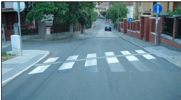
Bezpečnější typ šikmého přechodu přes vozovku
